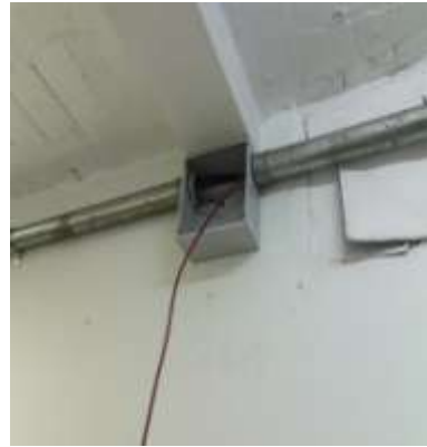
INSTALACIÓN DE TUBERÍA MATRIZ DE 3 PULGADAS Y CAJETIN ELÉCTRICO DE PASO
